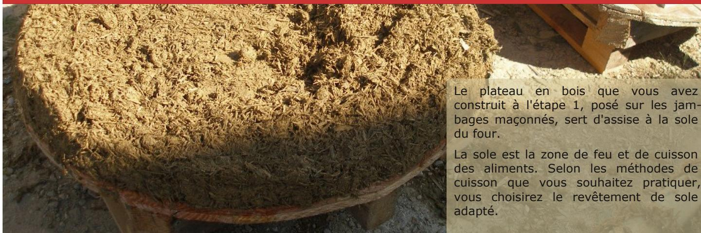
Le plateau en bois que vous avez construit à l'étape 1, posé sur les jambages maçonnés, sert d'assise à la sole du four.
